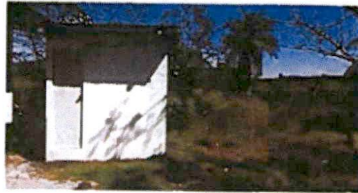
Unidades sanitarias terminadas por parte de la empresa.
