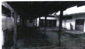
Esta área es la designada para colocar la caseta en la esquina al igual de área descarga y acceso de materiales.
