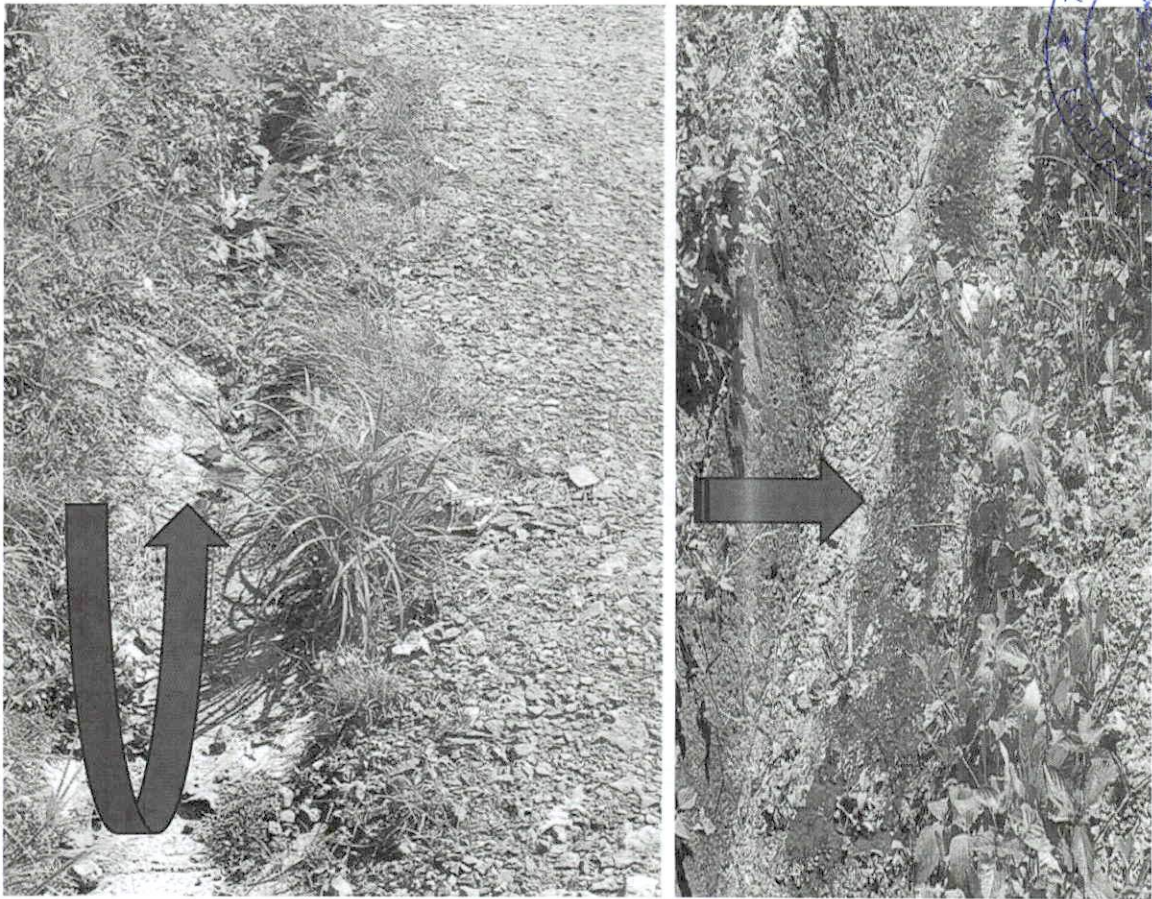
Vistas de la carretera a construir, algunas (pocas) con cunetas existentes y en su mayoría sin cunetas).
