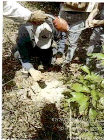
Río Año: hoyo de 30 cms de diámetro y 2.00mts (6.56pies) de profundidad
